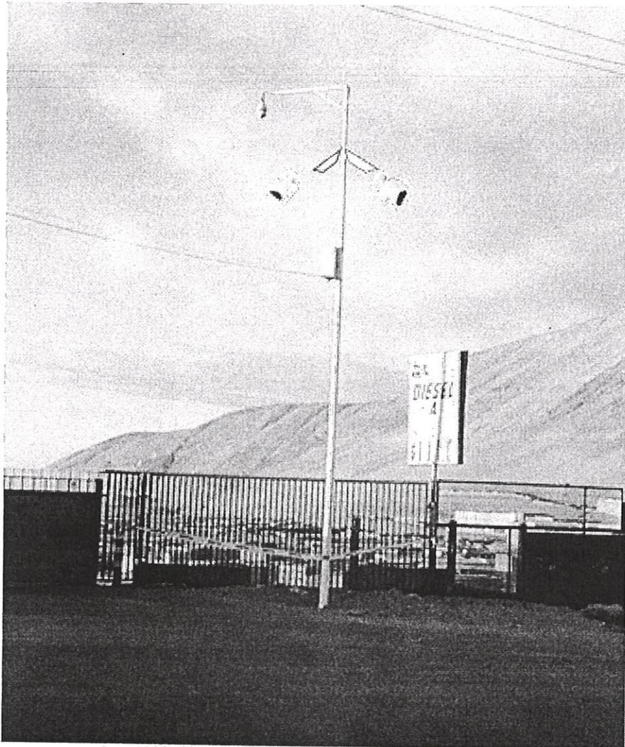
3.2. Conectividad de dos cámaras balas IP a red de Fibra óptica mediante enlaces inalámbricos de punto a punto, hacia un edificio con fibra óptica del sistema de cámaras IMI.
