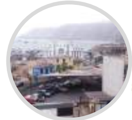
Deterioro de patrimonio
